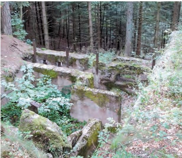
Fig. 36 : Le blockhaus allemand du Collet. Le blockhaus avait été construit en appui sur un rocher aménagé. Le béton avait été coulé dans un coffrage fait de traverses de chemin de fer en acier. Il y avait quatre postes de tir isolés par une chicane du reste du bâtiment.
