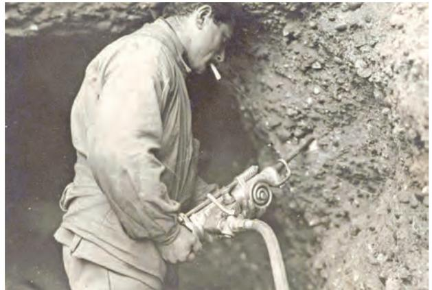
Fig. 42 : La Chapelotte (N. de Celles). Perforatrice en action. Creusement d'une sape dans le rocher (Conglomérat principal) 12 mars 1917. La Contemporaine VAL 157/095.
