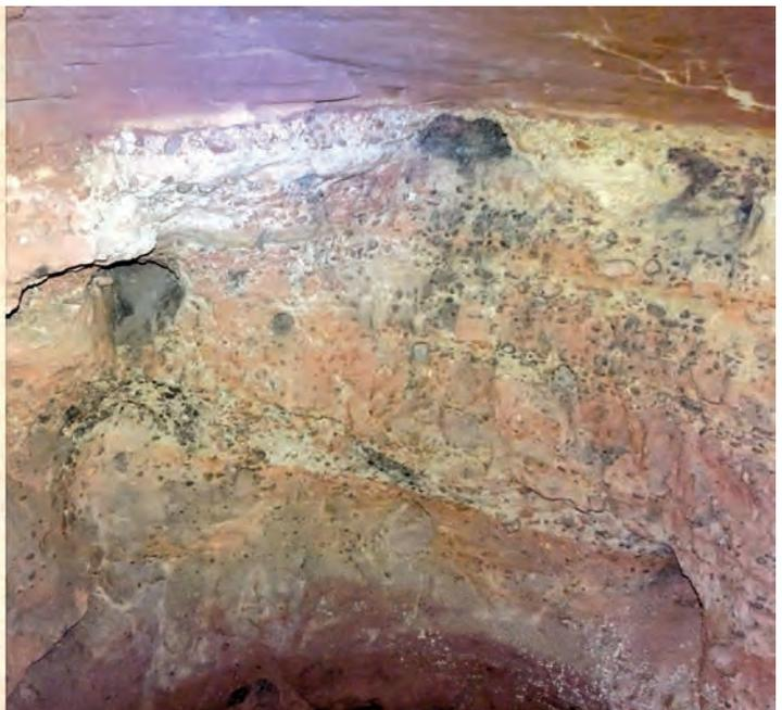
Fig. 43 : Traces de pétardement dans l'abri de la génératrice. Utilisation du perforateur à main (Écoles du Génie, 1917).
